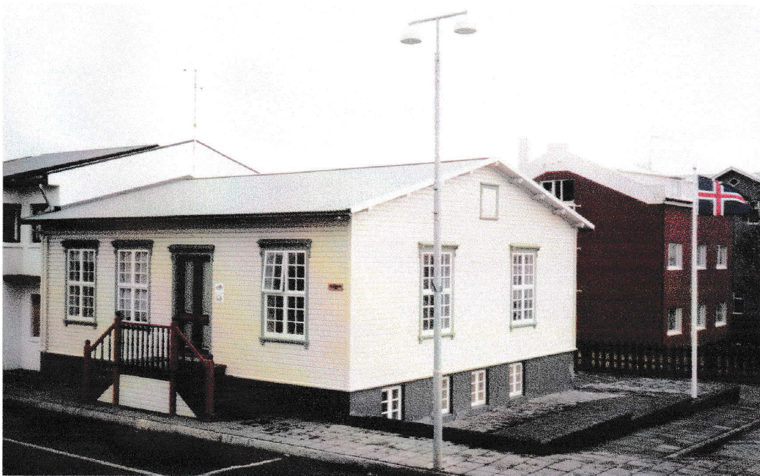
Mynd 1. Húsakynni Náttúrustofu Norðurlands vestra í "Gamla barnaskólanum" við Aðalgötu 2. Hann var byggður árið 1908, en hefur nú verið endurbyggður og er miðbæ Sauðárkróks til mikillar þýði.
